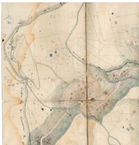
Le projet sarde de 1835 : amélioration de la route supérieure
