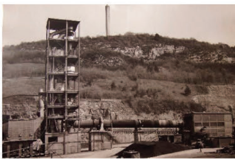
"Le dernier état du four à Montagnole (à gauche, le système de dépoussiérage)"
