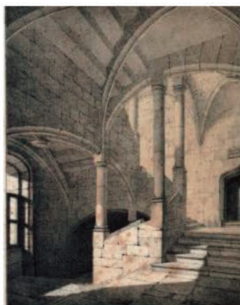
Escalier Aix en Savoie
