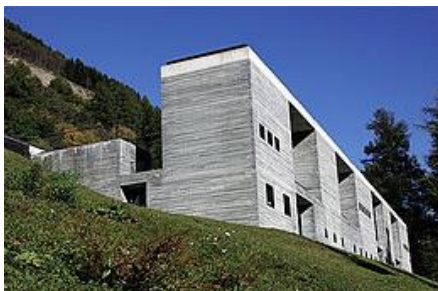
Aspect extérieur des thermes de Vals de Peter Zumthor
